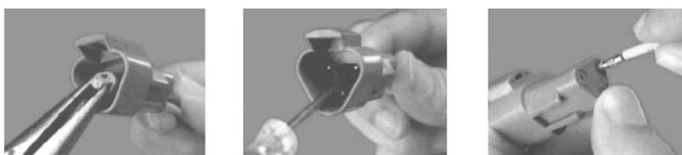
**Figura 7-13. Remoção do contato DT/DTP**
